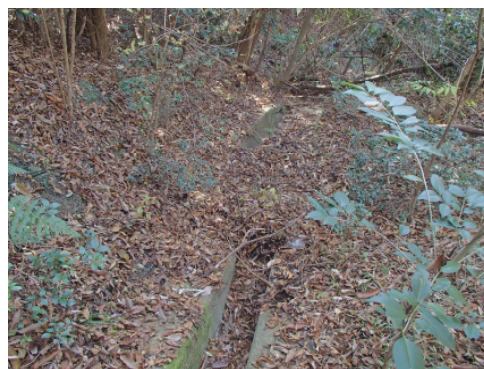
写真-3-4.8 縦溝の整備不良状況
