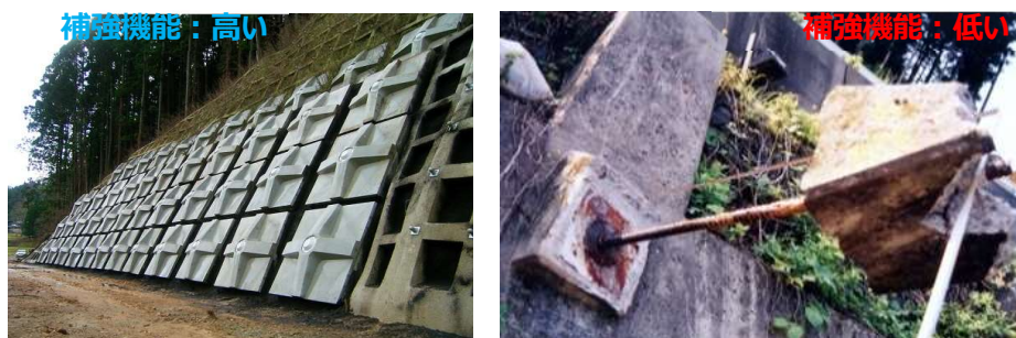
写真-2.2.2 道路盛土における補強機能の良悪例
