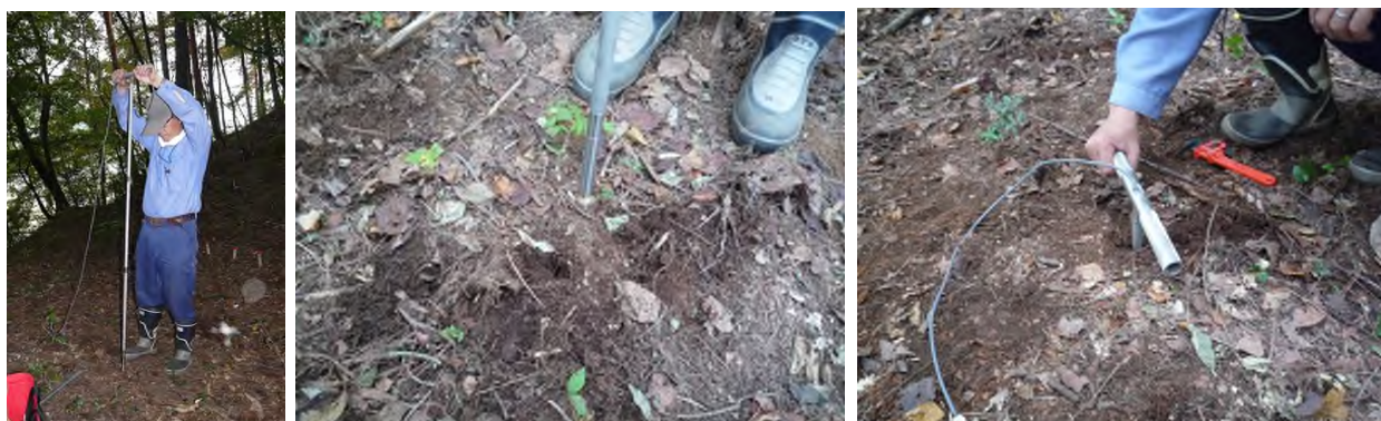
写真-3. 2. 7 小型間隙水圧計設置例
