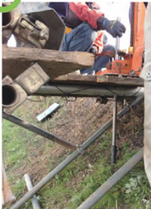
打ち込み用ロッドを保孔管内に挿入
