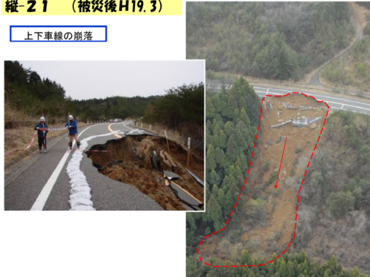
写真-3.1.1(e) 能登有料道路地震被害状況写真 (14.7kp、縦-21)
