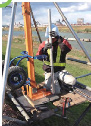
打ち込み式水位観測井の先端コーンおよび保孔管を設置地点にセット
