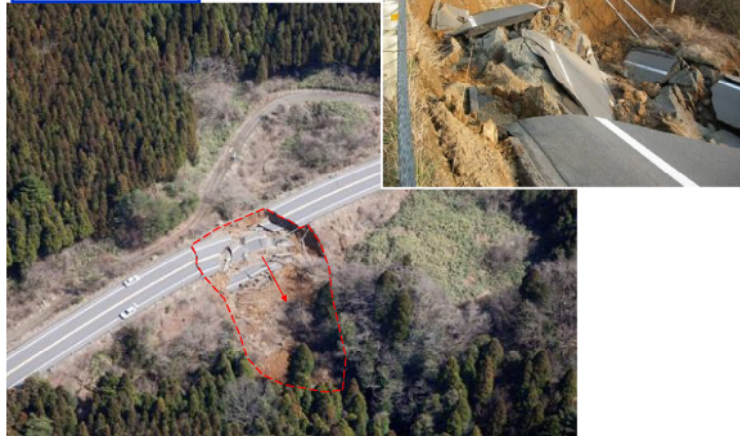
写真-3.1.1(d) 能登有料道路地震被害状況写真 (11.7kp、縦-14)
