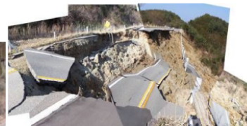
写真-3.1.1(g) 能登有料道路地震被害状況写真 (17.7kp、縦-32)
