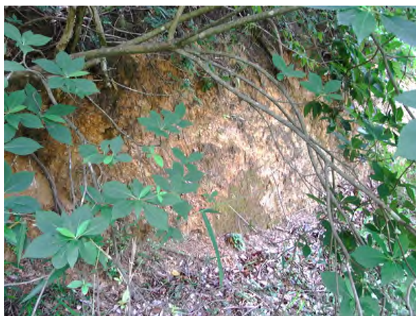
写真-3.5.1 近傍の切土面の状況（細粒分混り砂質土）
