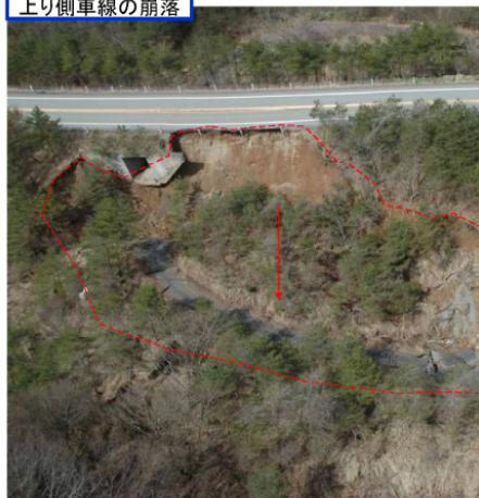
写真-3.1.1(i) 能登有料道路地震被害状況写真 (21.5kp、縦-39)
