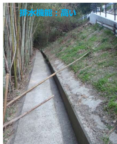
写真-2.2.1 道路盛土における排水機能の状態の評価例
