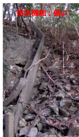
写真-2.2.1 道路盛土における排水機能の状態の評価例
