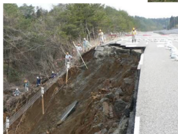
写真-3.1.1(g) 能登有料道路地震被害状況写真 (17.7kp、縦-32)
