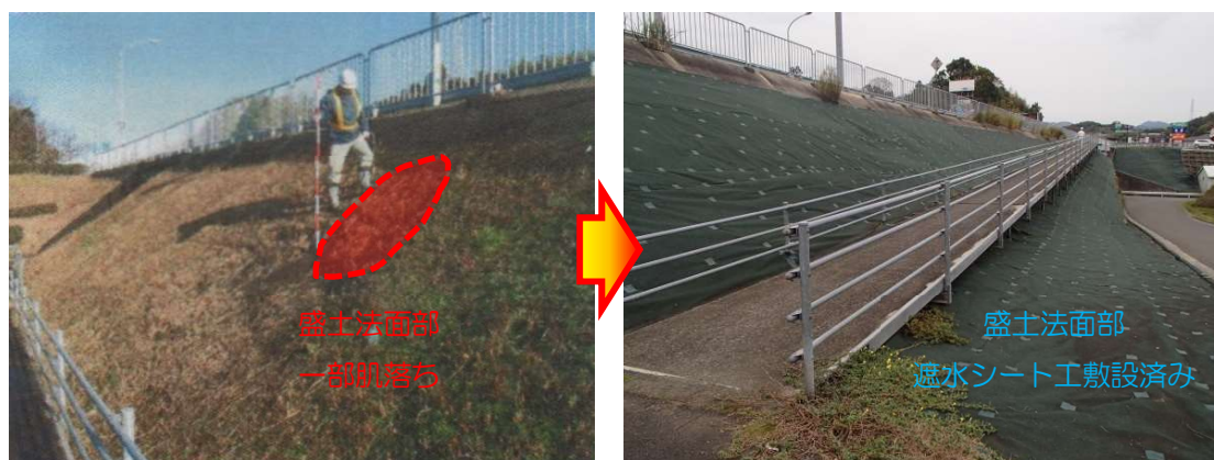
写真-2.2.3 過去に被災履歴があった道路盛土例
